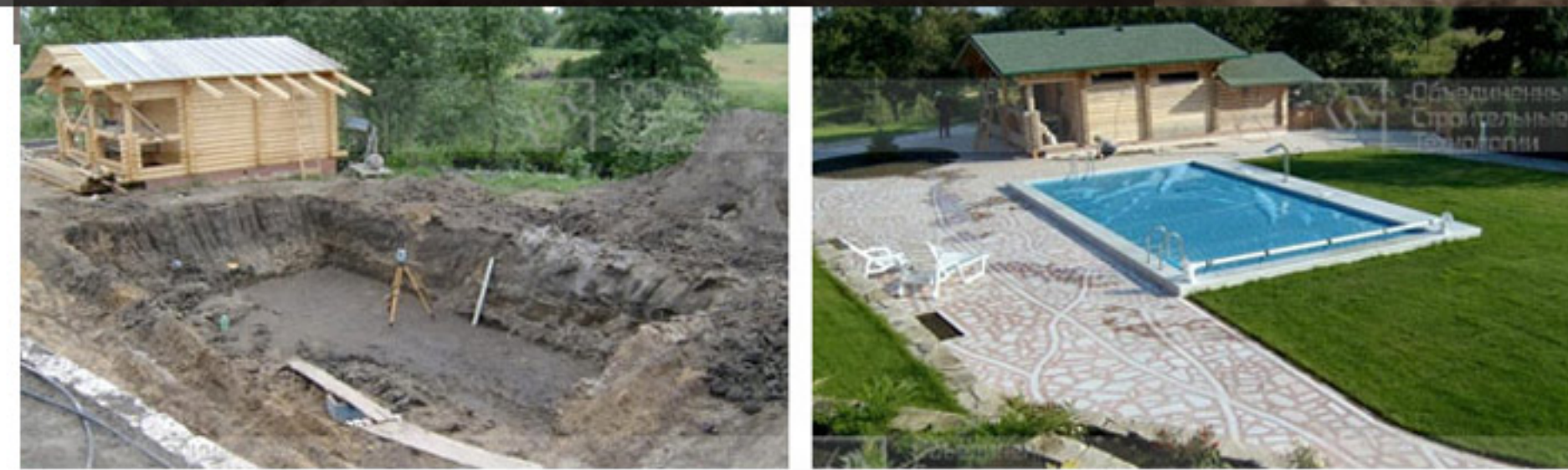
Фундаментные и свайные работы
